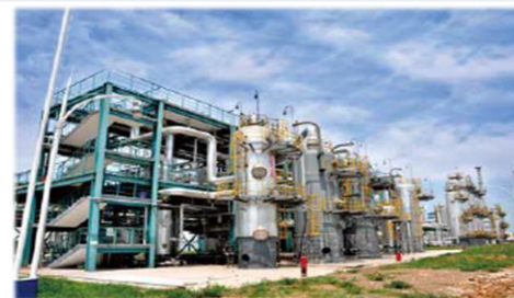
河南焦炉煤气制氢 制氢规模达2000万方/年
